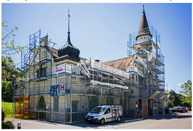
Vor allem an der Westseite und am Turm musste der Verputz abgeschlagen und ersetzt werden. Zu gross war jetzt die Gefahr, dass die Mauern und damit die Substanz des Schützenhauses Schaden erleidet und eine später Sanierung viel teurer kommen wird.
